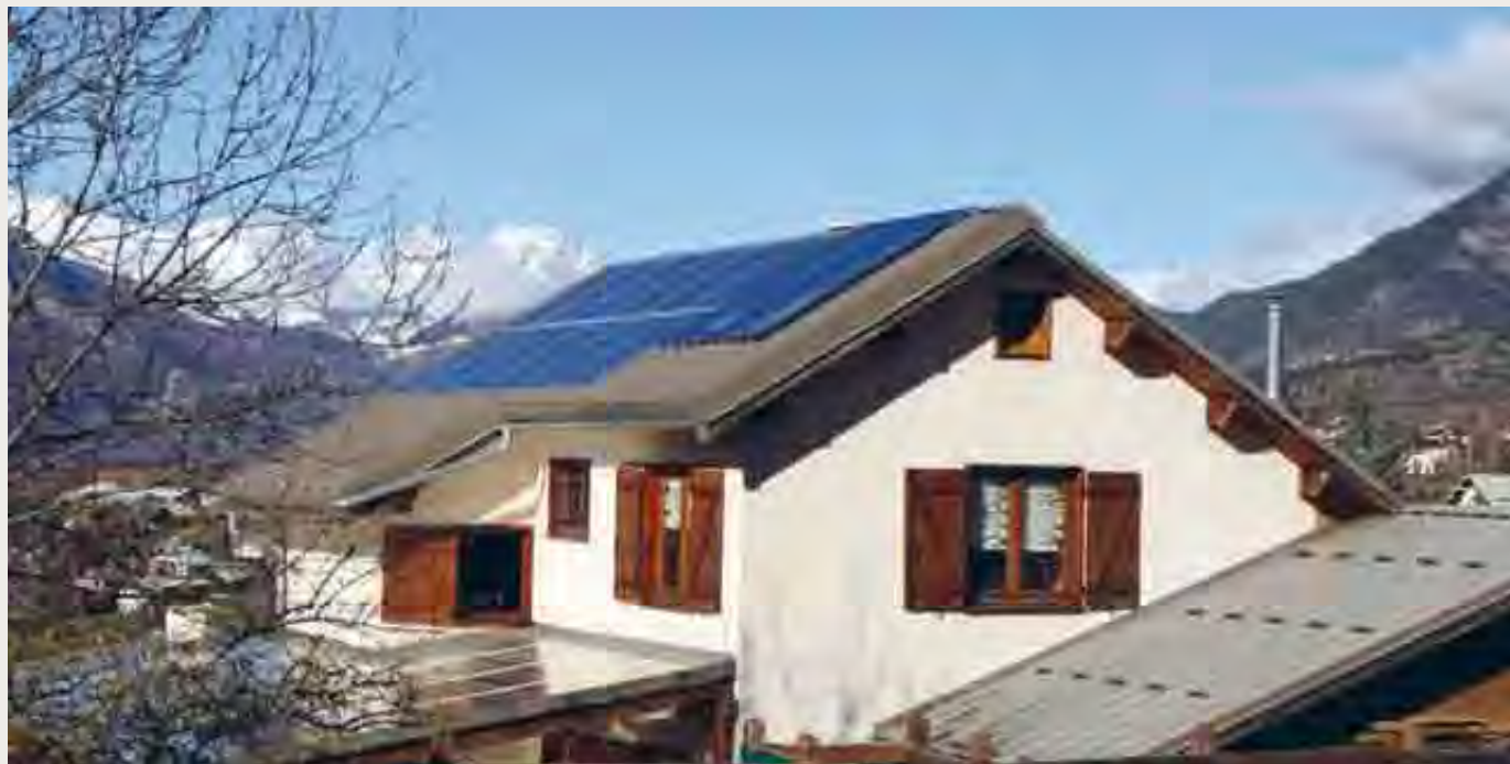
Guillestre : Solaire photovoltaïque et thermique en toiture et en couverture de véranda
