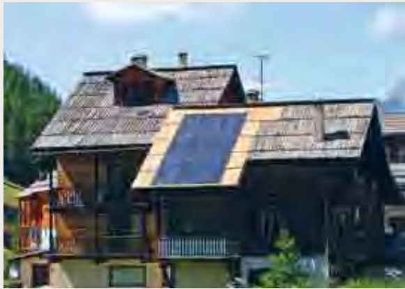
Molines : capteurs intégrés dans une couverture en bardeaux de mélèzes. La partie neuve en mélèze va griser rapidement
