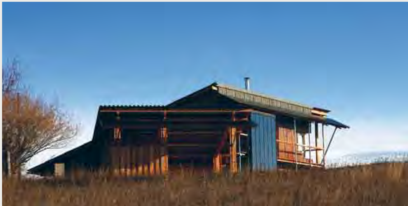
Basse Corréo, La Roche-des-Arnauds : capteurs solaires verticaux, et en auvent avec une fonction de brise-soleil
