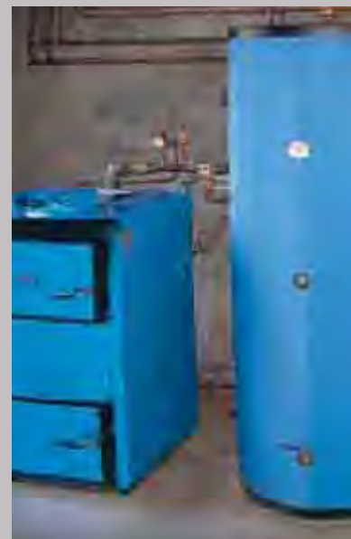
Installation thermique de type SSC
