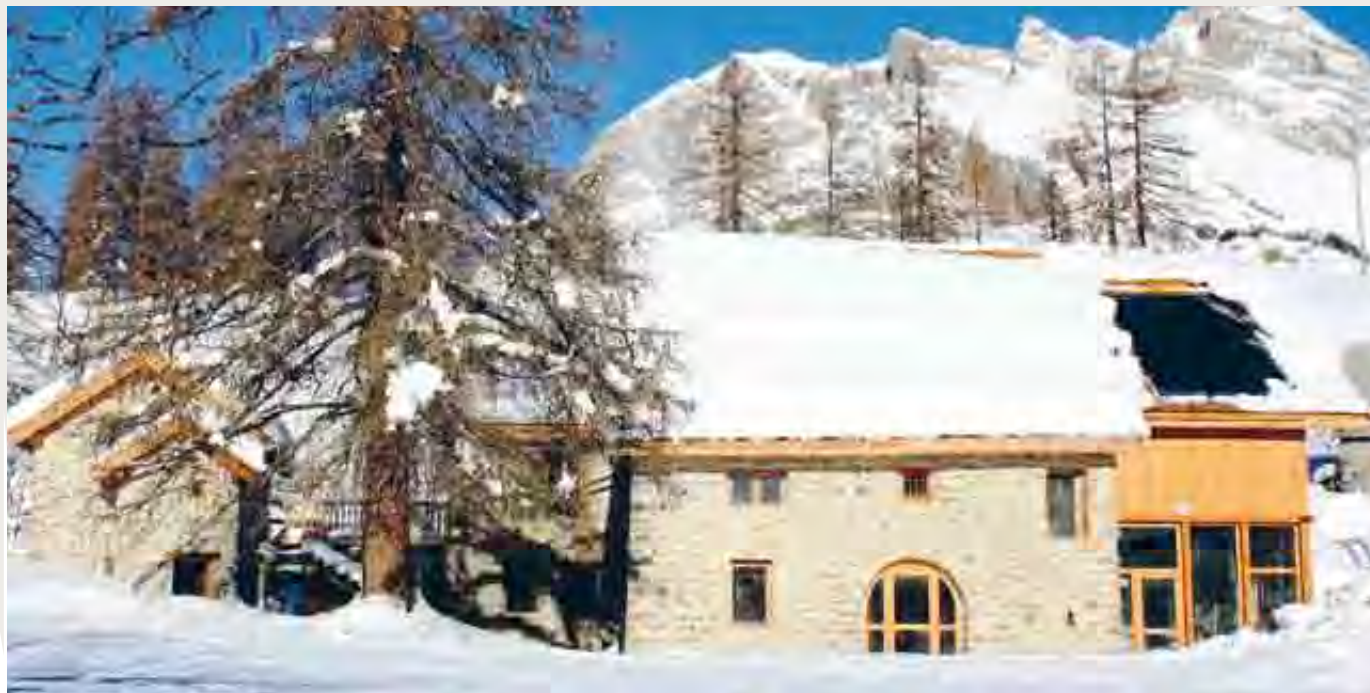
Le Fontenil, Le Monétiér-les-Bains : Le enneigement important en altitude n'est pas un obstacle au fonctionnement des capteurs solaires
